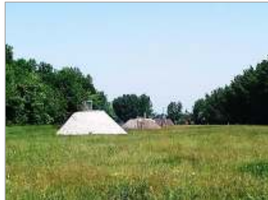
2. kép. A vízbázisra telepített parti szűrésű csökutak (Forrás: Baki Zoltán, BÁCSVÍZ Zrt. 2018.) Photo 2. Bank-filtered water wells installed on the subsurface water resources (Zoltán Baki, BÁCSVÍZ Zrt. 2018)
