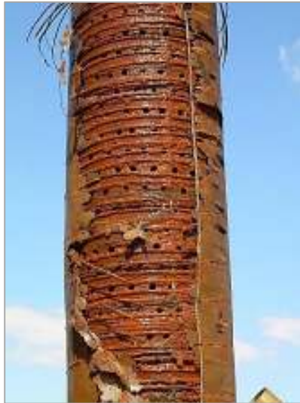
7. kép. Vas-oxid bevonat a kútból kiépített szűrőrákaton (Forrás: BÁC SVÍZ Zrt.) Photo 7. Iron oxide coating on removed filtered well (Source: BÁC SVÍZ Zrt.)
